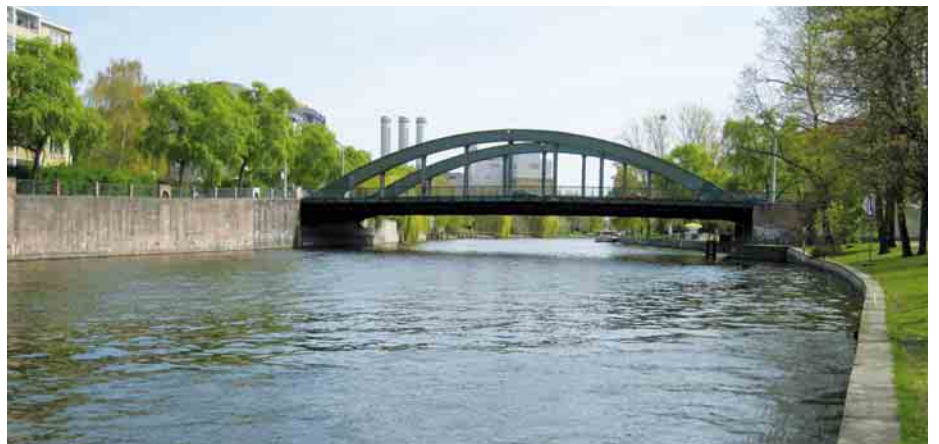
Mischwasserüberlauf an der Schlossbrücke beim Schloss Charlottenburg
