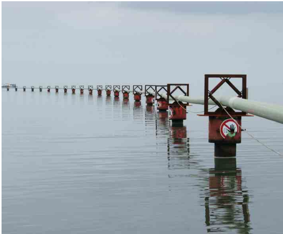
ERSETZT DIE ÖLTANKER: Rohrleitung durch das Wattenmeer
