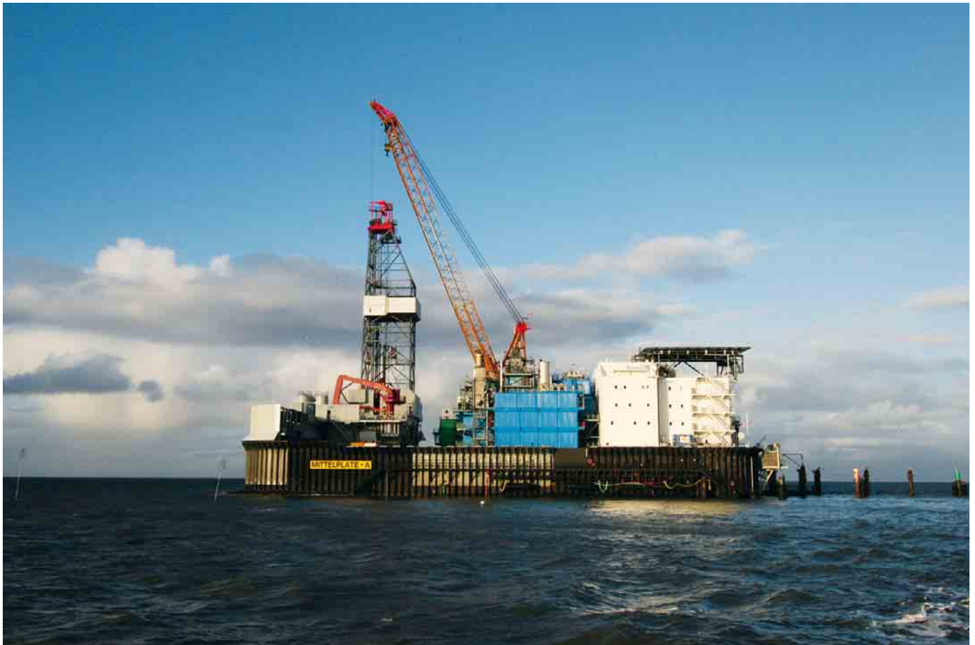
IM WATTENMEER: Bohr- und Förderinsel Mittelplate
