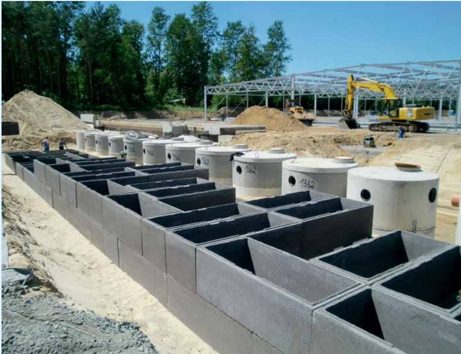
Sickerkammern aus Beton, auch zum nachträglichen Einbau in oberflächennahe Bodenschichten geeignet.
