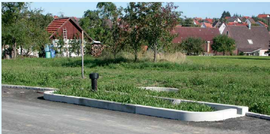
Grundwasserneubildung durch Versickerung des Straßenabflusses über die belebte Bodenzone. Innodrain, ein Tiefbeet aus Betonfertigteilen, mit darunter angelegter Rigole. Die anschließbare Fläche entspricht herkömmlichen Entwässerungsabschnitten.
