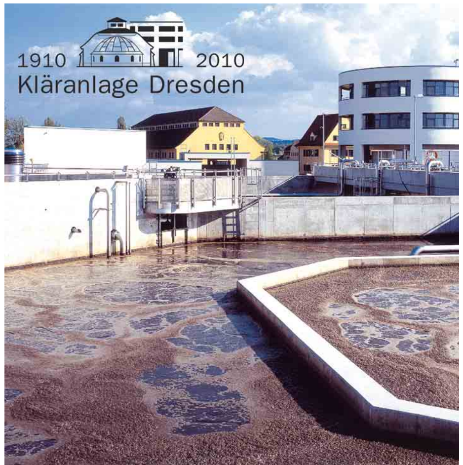
DIE NEUEN BAUWERKE – hier die biologische Abwasserbehandlung – sind formvollendet im historischen Areal integriert, 2005
