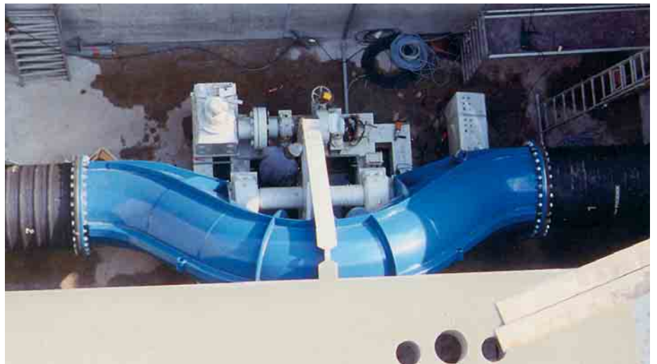
DRESDEN-LEUBEN: eingebauter Drehbogen
