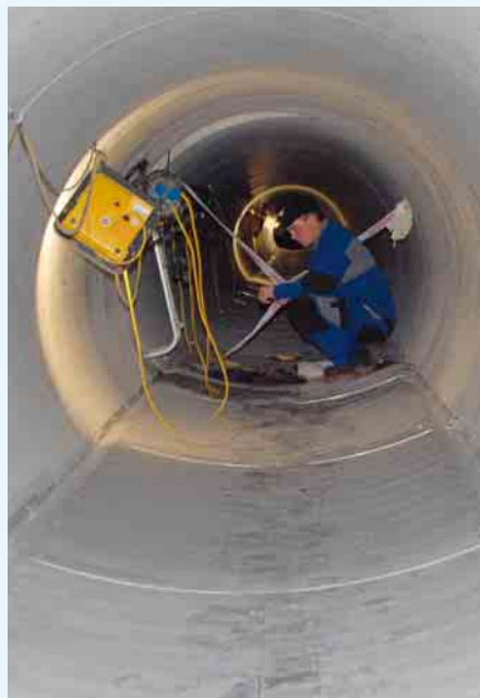
IM KANAL VERLEGT: ein Rinnenwärmetauscher
