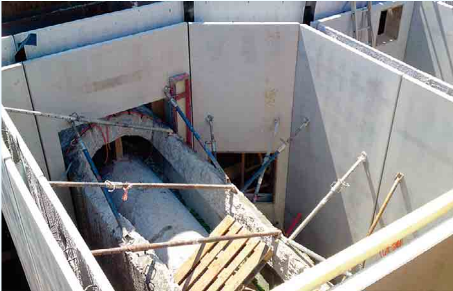
Schachtbauwerk zur Aufnahme der Nebensammler und der Siebanlage
