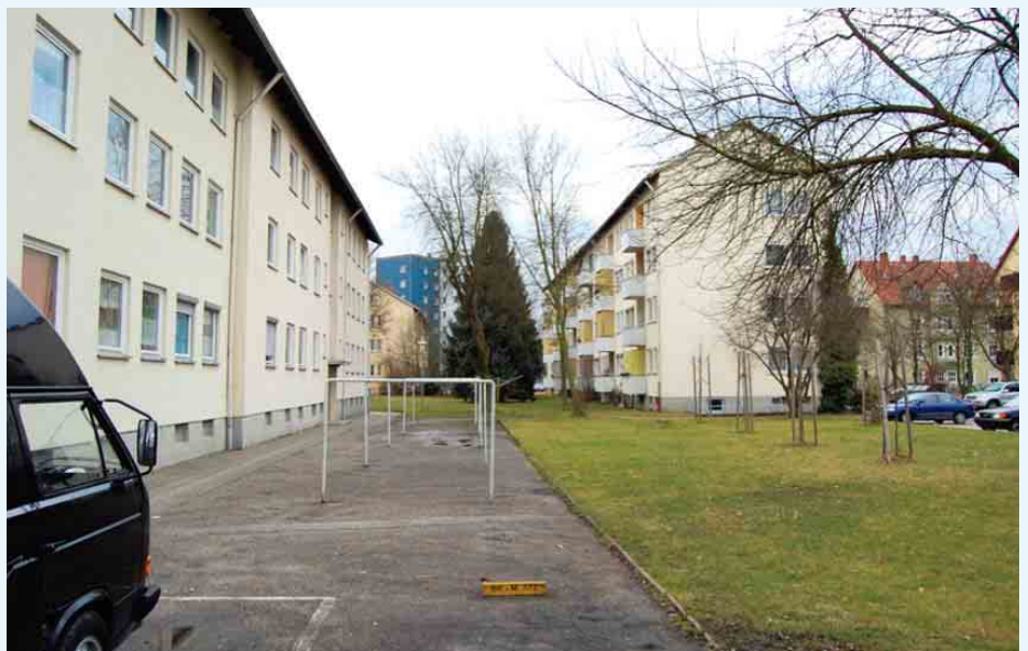
Ansicht der energetisch zu sanierenden Wohngebäude in der Sudetendeutschen Straße, Straubing Bild 7
