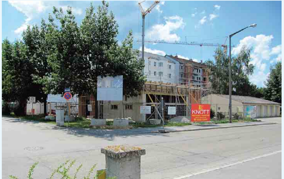
Ansicht des Technikgebäudes (vorn) und der Wohngebäude während der Sanierung
