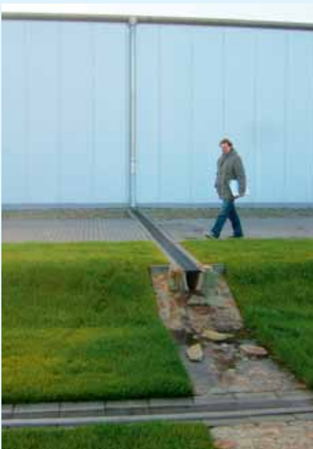
Dachablauf in die Sickermulde
