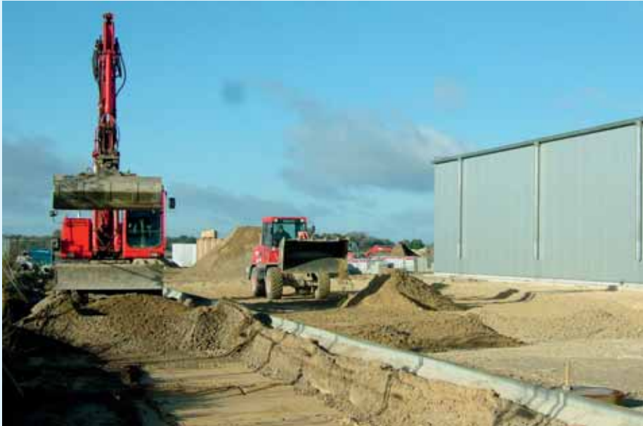
Betriebserweiterung im Jahr 2010 mit ca. 12.000 m 2 Hallendachfläche und ca. 1.650 m 2 asphaltierter Oberfläche
