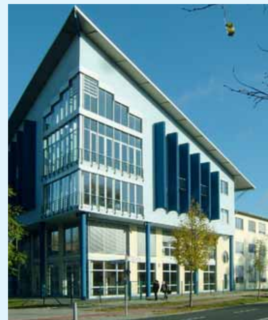
Firmenzentrale Wisch Engineering, Staaken/Berlin
