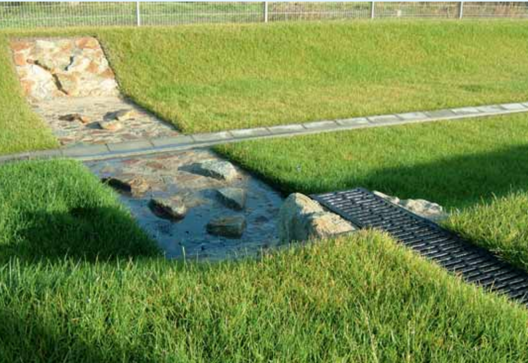
Sickermulde für Dachwasser entlang der neu gebauten Produktionshalle
