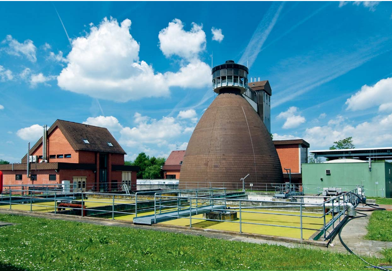
Bild 2 Faulbehälter der Kläranlage Darmstadt-Süd
